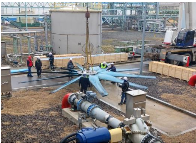
기존 팬(Fan) 철거작업
