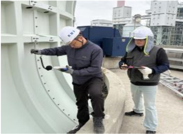
신규 팬(Fan) 시운전 및 시험
