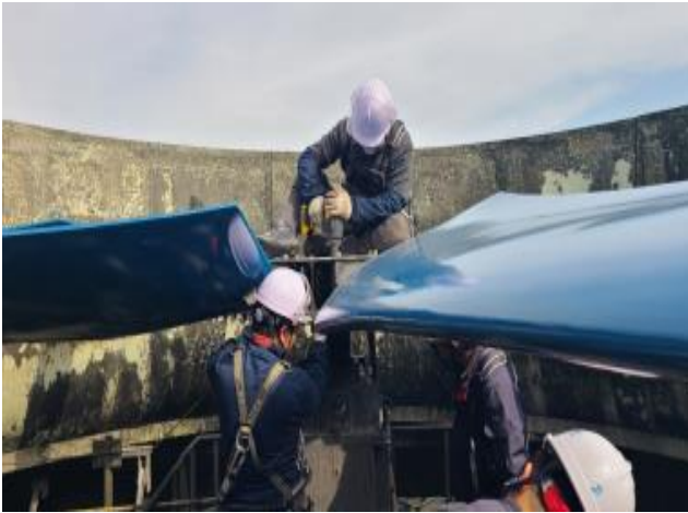
신규 팬(Fan) 설치작업
